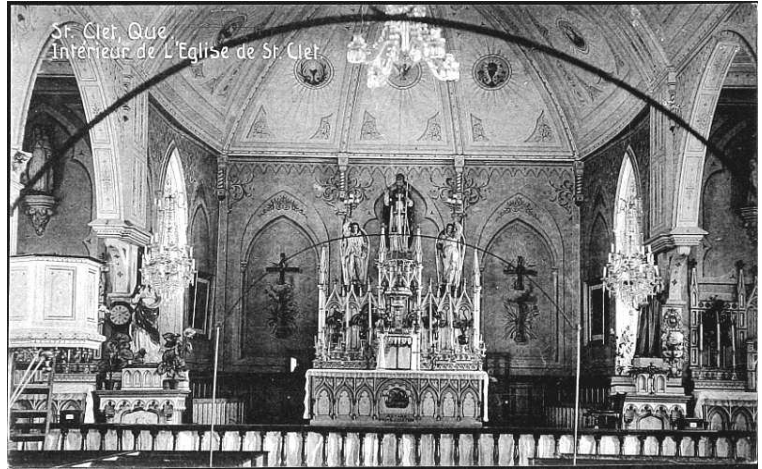
Intérieur de la 1ère église de St-Clet (1850). Du à la fragilité des fondations, elle fut démolie en 1926 pour faire place à une 2 e église (1927). Photo : Archives nationales du Québec.
