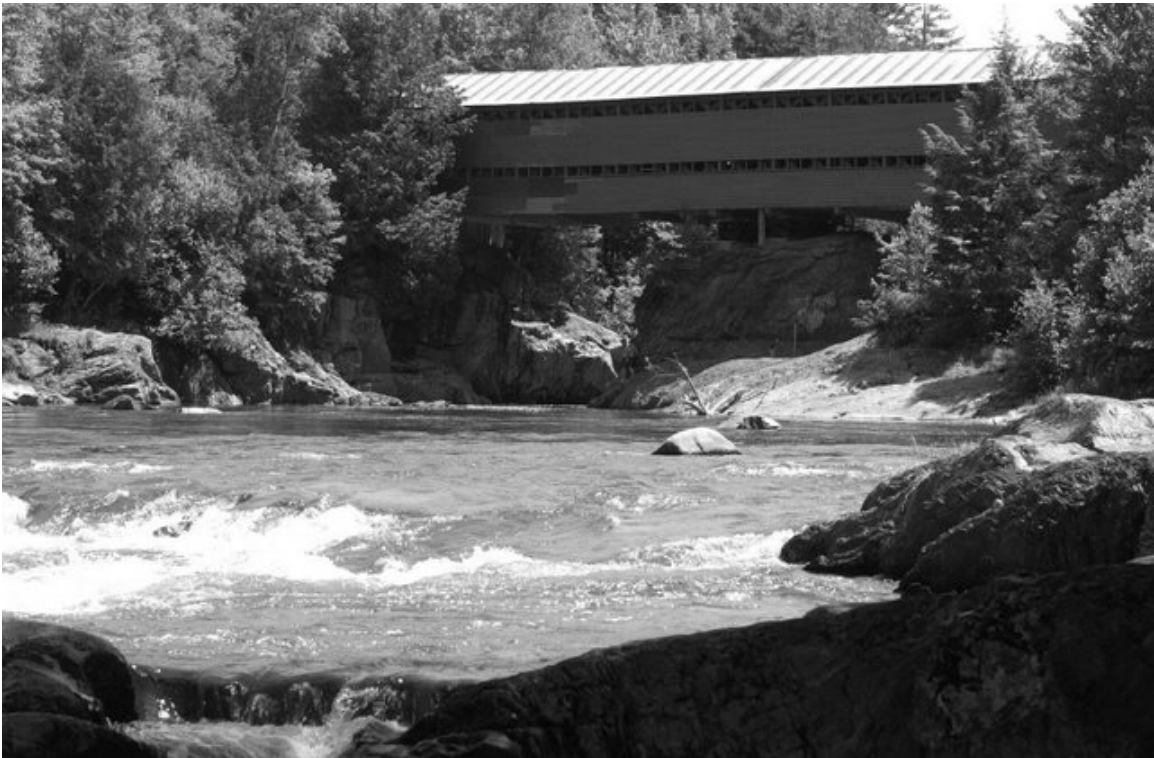
Sainte-Agathe-de-Lotbinière : Pont Couvert. Le pont construit en 1928 est en service saisonnier. Il est situé sur le chemin Gosford.
